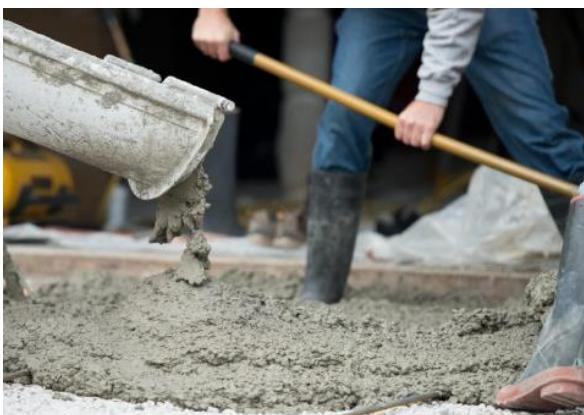
**الخرسانة** يطلق عليها خلاطة الباطون، وهي خلاطة مكونة بشكل أساسى من الرمل، والإسمنت، والماء، تستخدم في تدعيم أساسات البناء، وصب الأسطح، وتشييد الطرقات، وغيرها.
